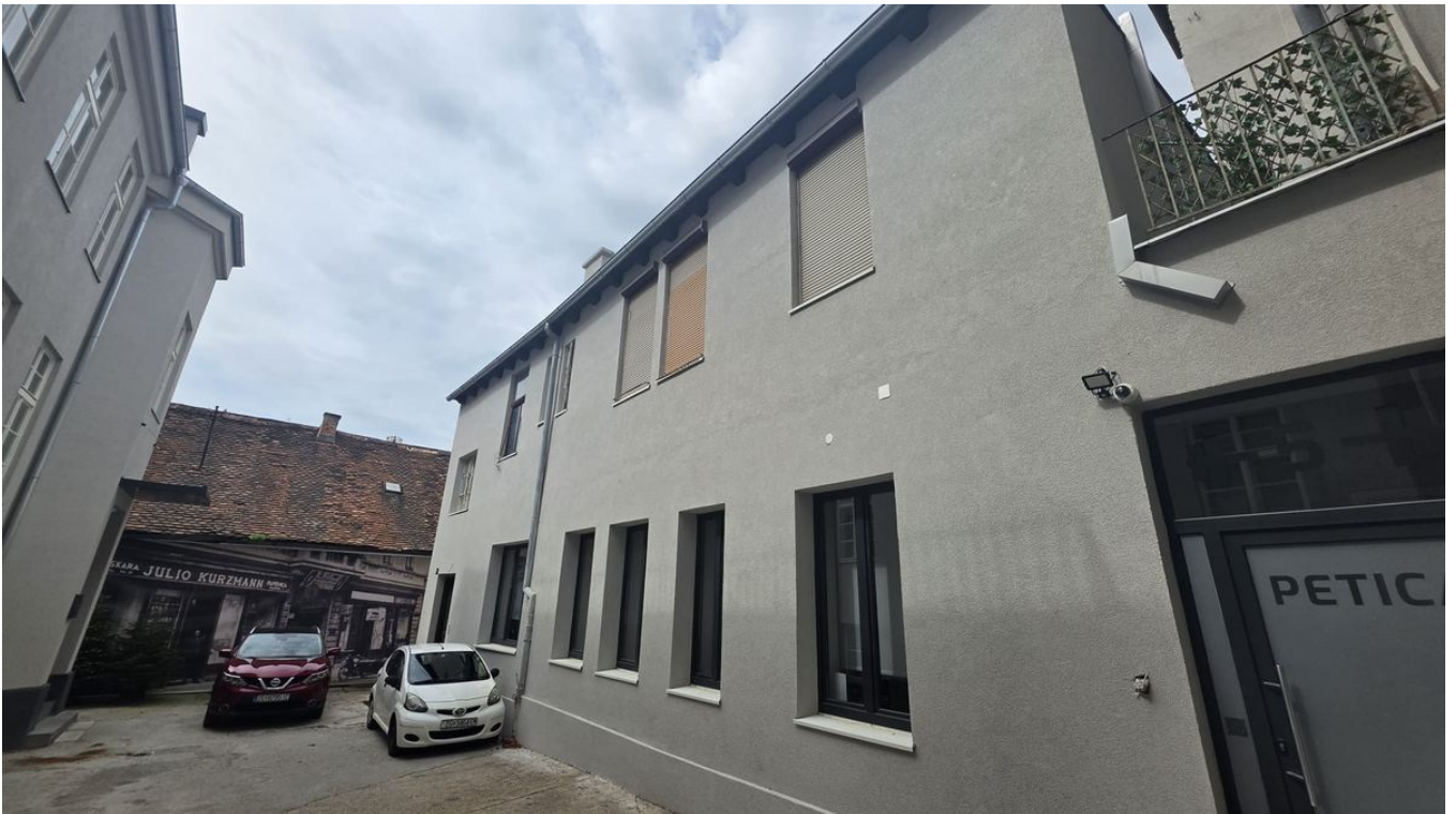
Pogled na obnovljeni objekt — Dalmatinska 5/1
