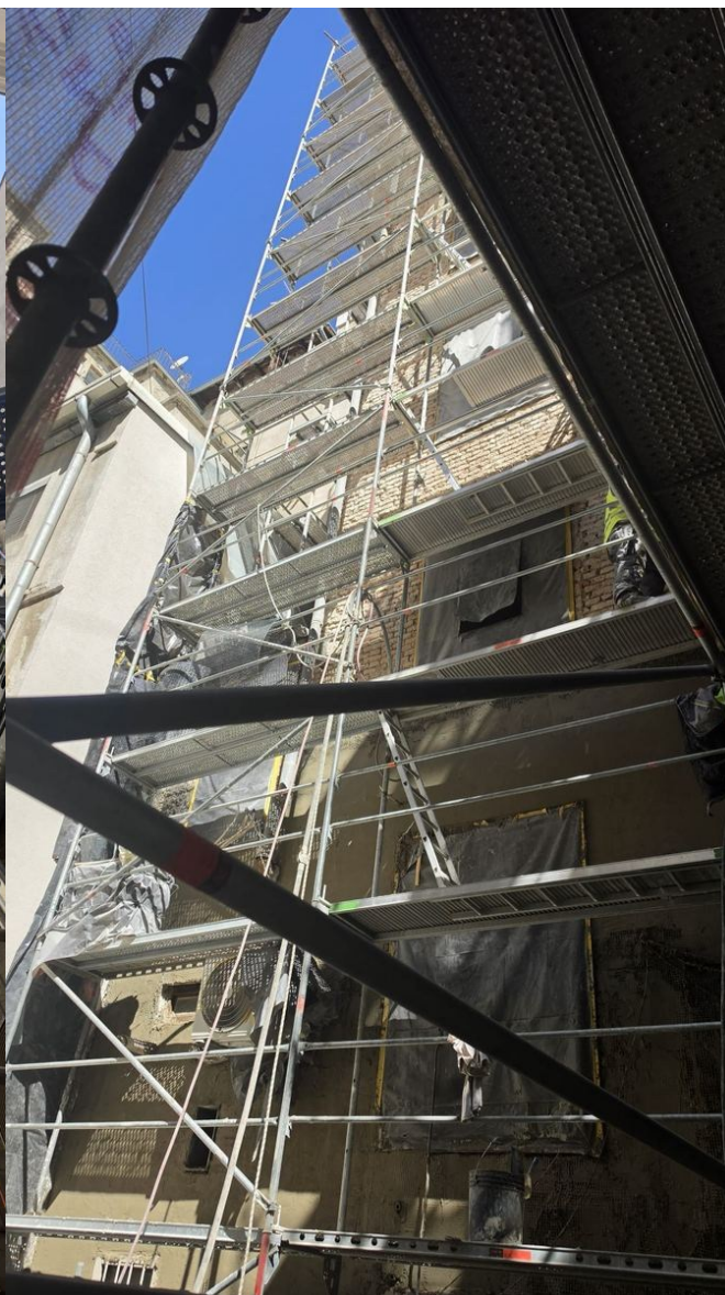
Fasadna skela — ojačanje vanjske konstrukcije
