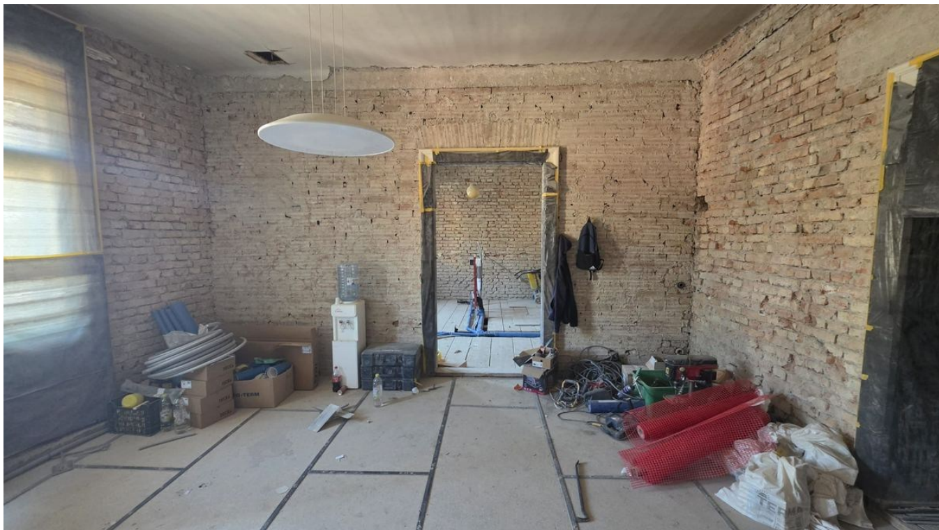
Sanacija nosivih zidova i nova međukatna ploča
