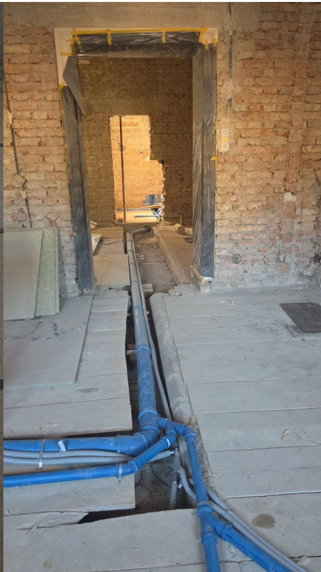
Zamjena podnih konstrukcija i instalacija
