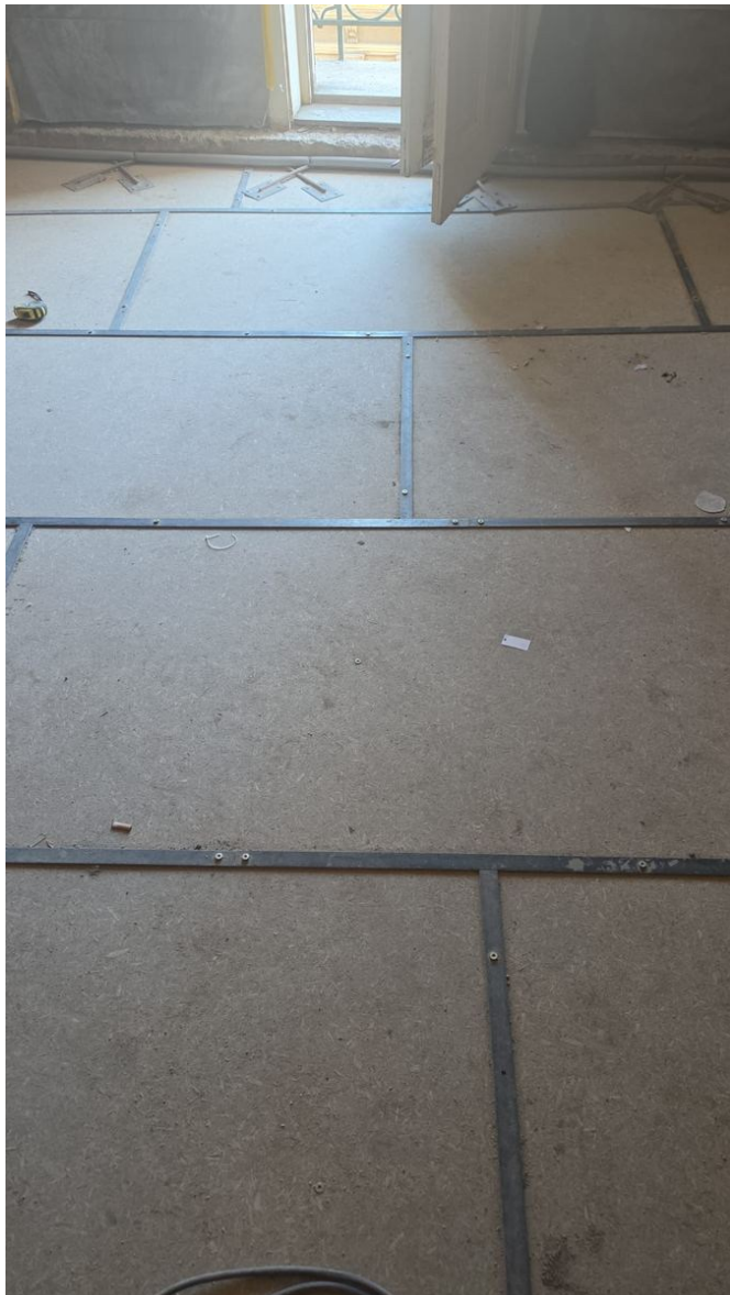
Nova međukatna konstrukcija — čelični profili i OSB ploče
